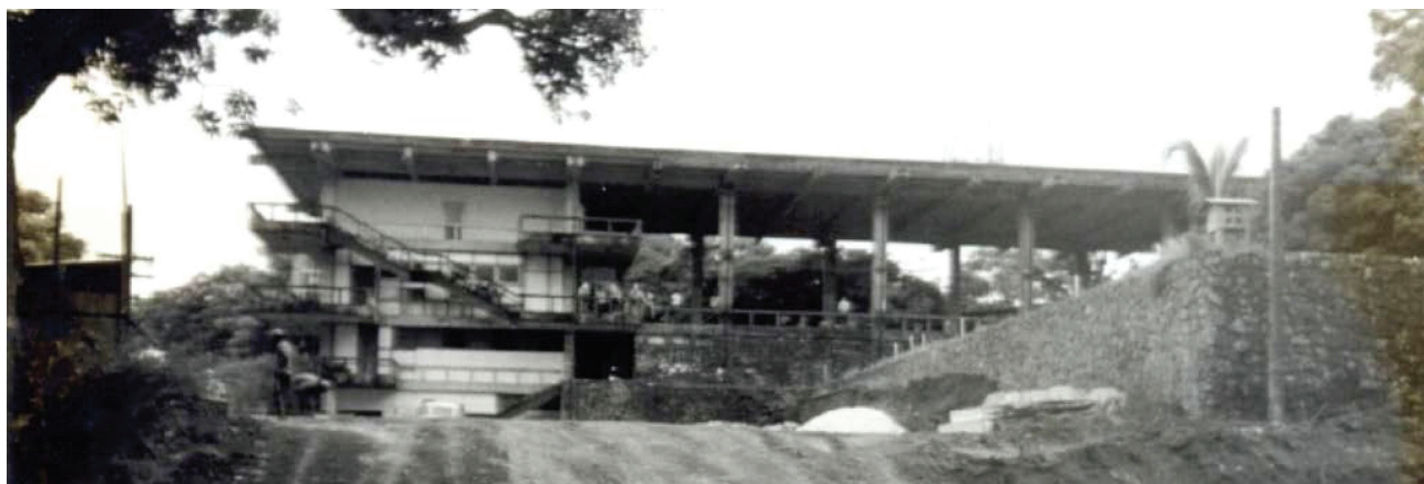
Figura 08 | Fachada Sul, sem o mezanino. A fachada sul, com o pátio e sua verticalidade dominante antes do mezanino, bem como a escada lateral, um acesso posteriormente incorporado ao piso criado pelo mezanino, articulando os pisos das cotas 49,00 à 52,50m Fonte: ANDRADE (1989)
