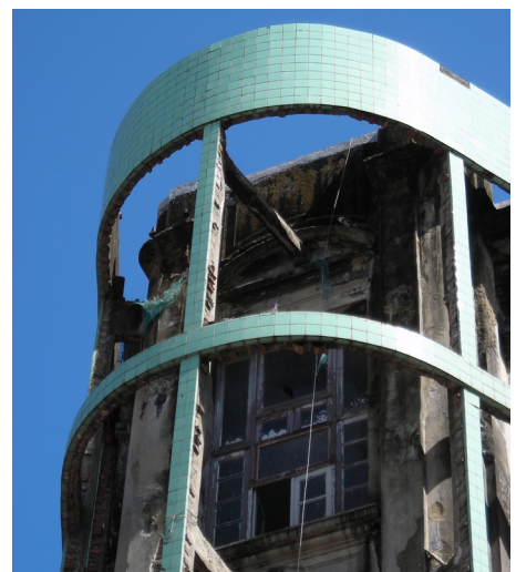
Figura 17 | Edifício Luciano Costa: Estrutura de suporte, durante obras de remoção da superfície de elementos vazados em 2007. 17a: Detalhe da fachada da Avenida Rio Branco; 17b: Detalhe da fachada da Avenida Rio Branco; 17c: Detalhe da fachada da Rua do Bom Jesus; 17d: Detalhe da esquina ruas Dona Maria César e do Bom Jesus Fotos: Luiz Amorim
