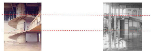
Figura 18 | Croquis / fotos – escadas existentes aproveitadas
