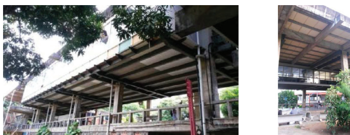
Figura 30 | Vistas do vigamento principal (articulação aço & concreto)
