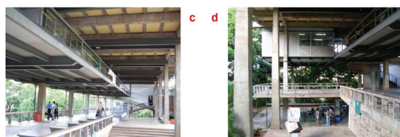
Figura 27 | (a,b,c,d) – Vistas do pórtico: relações entre interior x exterior.
