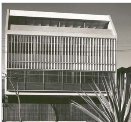
Residência Antonio Ceppas
