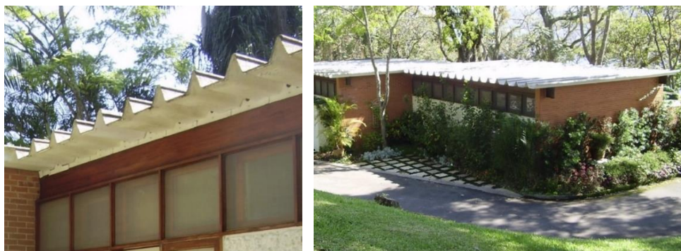
Figuras 10 e 11: Prancha de apoio da cobertura, e cobertura
