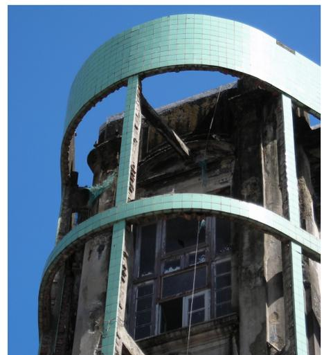
Figura 17 | Edifício Luciano Costa: Estrutura de suporte, durante obras de remoção da superfície de elementos vazados em 2007. 17a: Detalhe da fachada da Avenida Rio Branco; 17b: Detalhe da fachada da Avenida Rio Branco; 17c: Detalhe da fachada da Rua do Bom Jesus; 17d: Detalhe da esquina ruas Dona Maria César e do Bom Jesus
