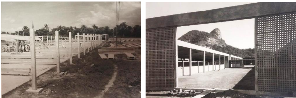
Figura 4 e 5: Fotografias da construção do Sanatório de Curicica e seus elementos pré-fabricados no canteiro de obras.
