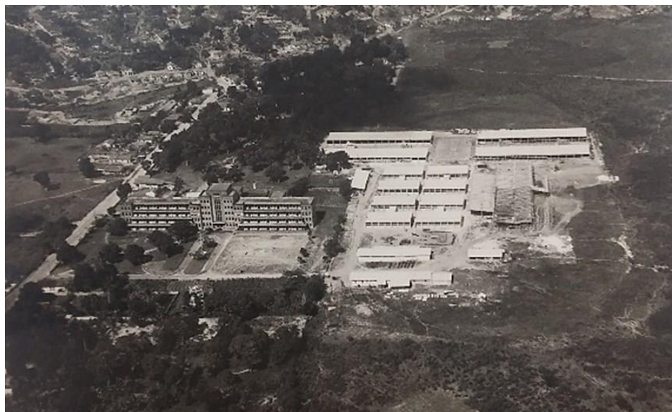
Figura 3: Fotografia da obra do Sanatório de Sancho, 1956 e atualmente, como Hospital Otávio de Freitas, Tejió. Recife, PE.
