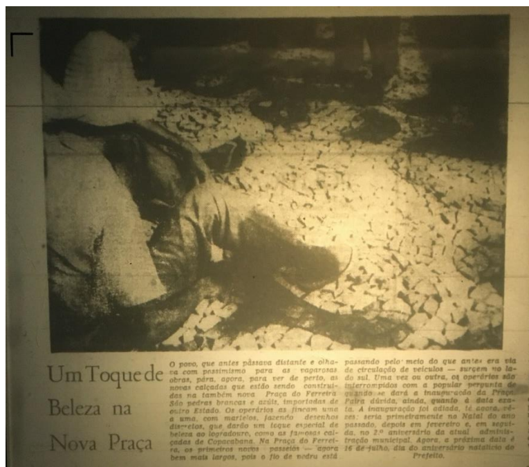
Figura 11: Revestimento da Praça em execução, com paginação geométrica no “padrão Copacabana”, conforme noticiado pelo jornal O Povo.
