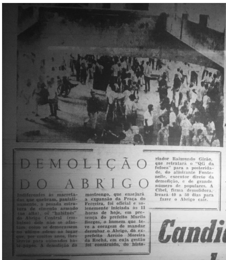
Figura 3: Demolição do Abrigo Central noticiada no jornal O Povo.
