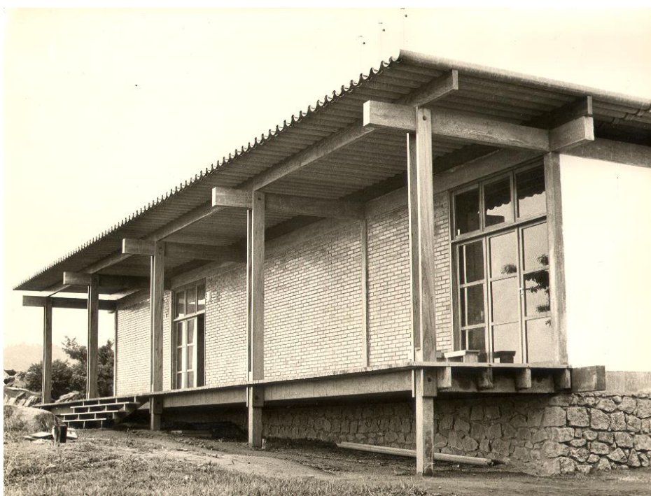
Figura 1: Edifício Escritório de Campo (1967), também conhecido como "Catetinho" ou "Castelinho", no campus universitário da UFES.
